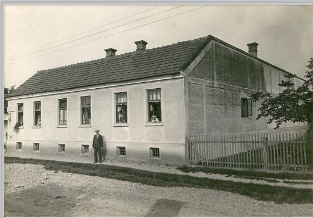
J. Purač, Cvetkova hiša v Mali Kaniži (danes Partizanska ulica), Murska Sobota, 20. 6. 1936. V tej hiši je pred II. sv. vojno živel in delal krojač Josip Cvetko. Njegov brat je imel v kletnih prostorih čevljarstvo delavnico. Istočasno je v prizidku na dvoriščni strani delovala manjša pekarna. Dotrajano stavbo je novi lastnik podrl l. 2009.
